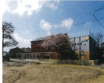
北東より見る
