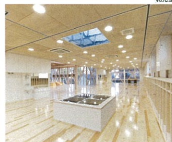
屋根から2階を貫いて1階に光を落すトップライト
