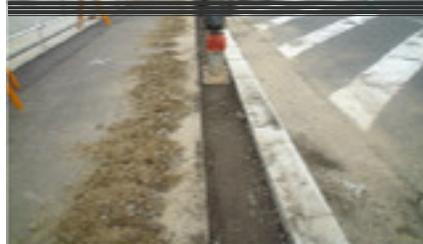
道路種類による規格の違いや、発注官庁によっては舗装材の打ち込み厚が違います。切りかけ部全体が隠れるように舗装材を打ち込む為、路盤など注意して埋設すること。
