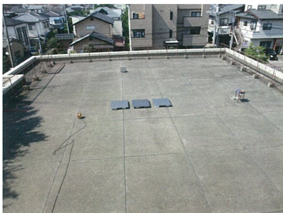
写真 3. 測定箇所から見た鉄板
