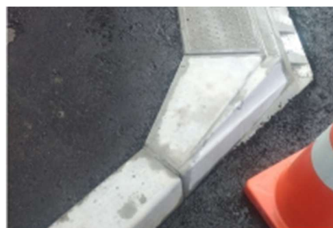
通常のバリアレス縁石の擦り付け部。現場ごとに特注の型枠を発注して製造する“一点物”である
