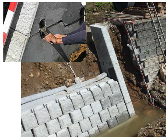
積ブロック・プレキャスト小口止ブロック設置
