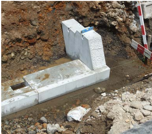
ブロック積み基礎小口止一体型設置
