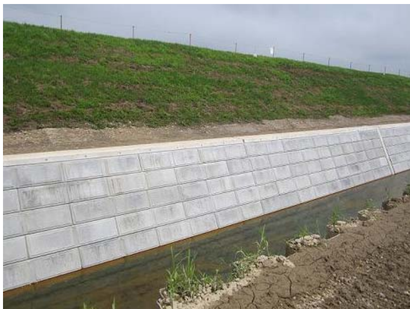
(写真-3.施工完了状況)
