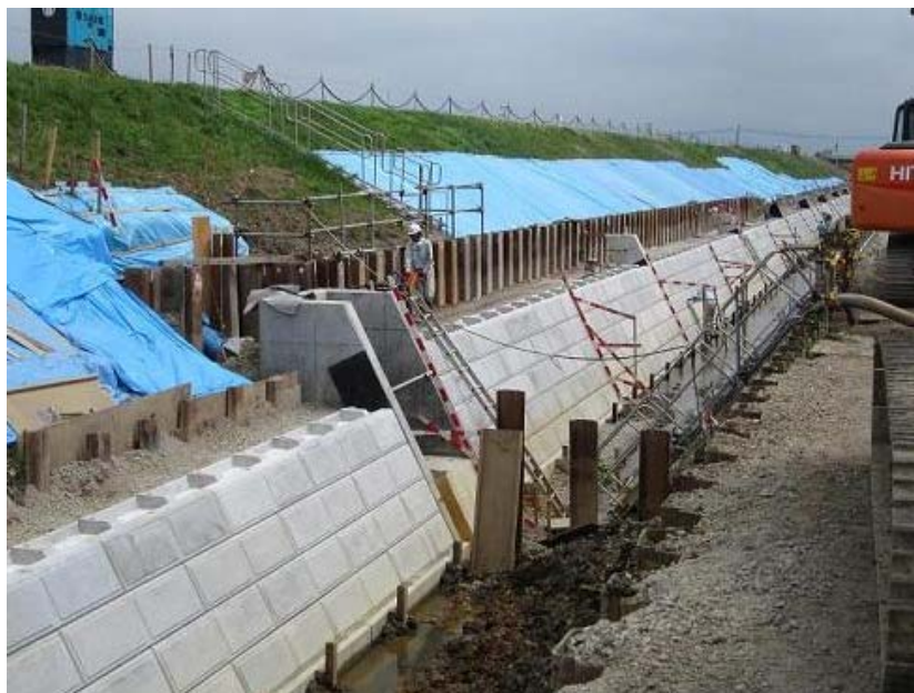
(写真-2.施工状況)
