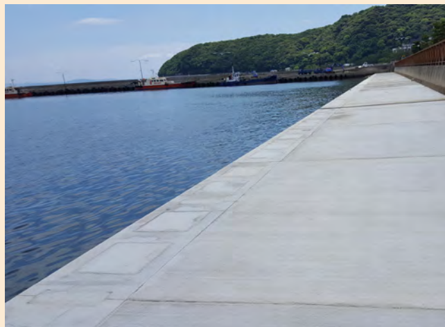
⑦施工完了
