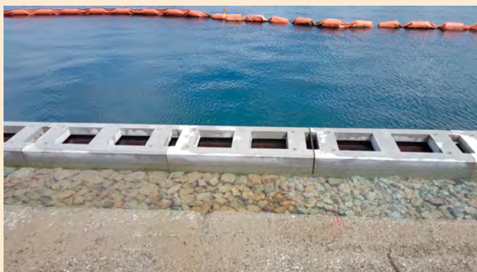
④笠コンブロック布設
