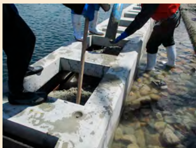
※水中コンクリート打設
