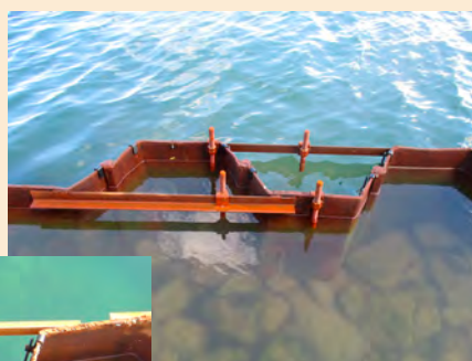
③高さ調整ボルト設置
