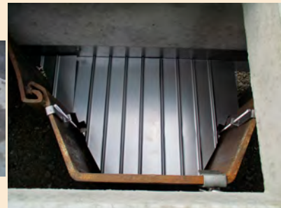
⑤底板プレート設置(参考写真)
