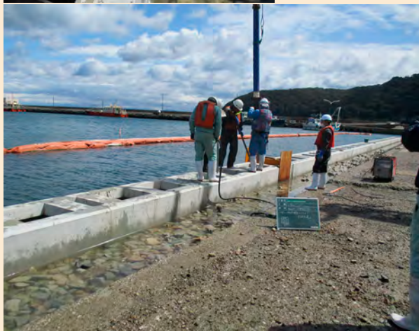
⑥中詰コンクリート打設
