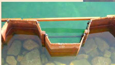
②プレート受材設置
