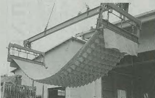
コニカルマットの吊り下げ状況
