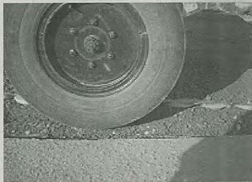
コニカルマット工法の施工状況
