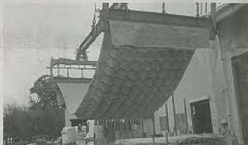
円錐形ブロックと高強度繊維シートを一体化したコニカルマット工法
