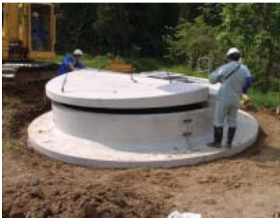
写真-1 集水井天蓋掛替え工事状況
