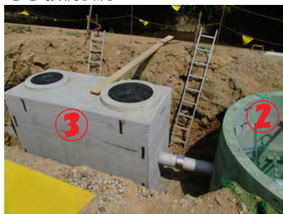
②③ 接続状況
