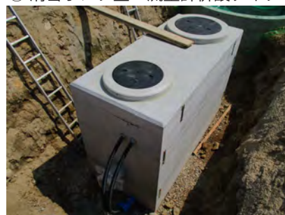
③ 消雪ポンプ室・流量計併設タイプ
