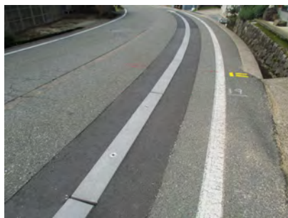
⑤ 消雪パイプブロック
