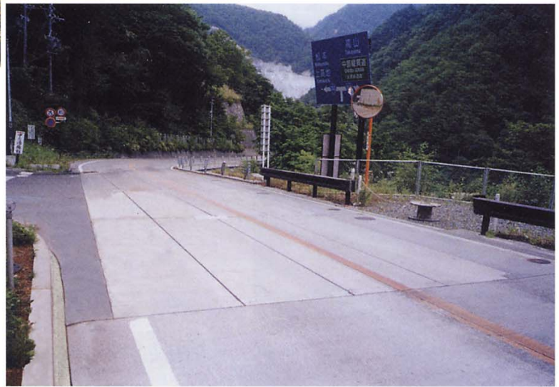
一般国道158号安房峠 (融雪装置埋設タイプ)
